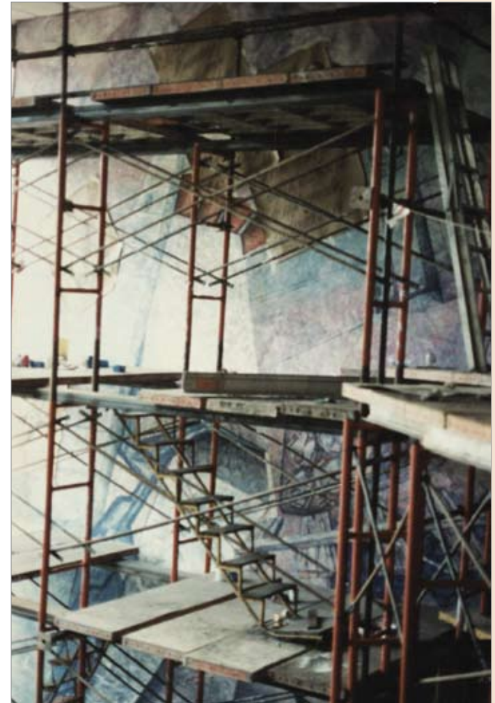
Estructura de andamiaje del mural "A través del espejo".
